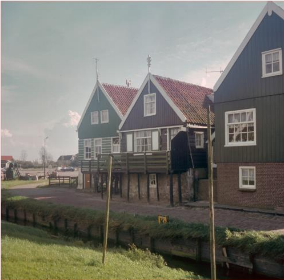
Figure 7a: Filling in the space between the piles of stilt houses (on the isle of Marken) (Image credit: Rijksdienst voor het Cultureel Erfgoed)
