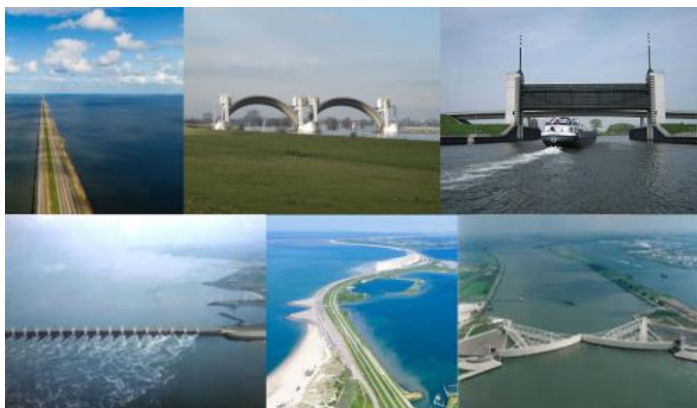
Figure 3: Afsluitdijk, large hydraulic locks, Delta Works (Image credit: Rijkswaterstaat)
